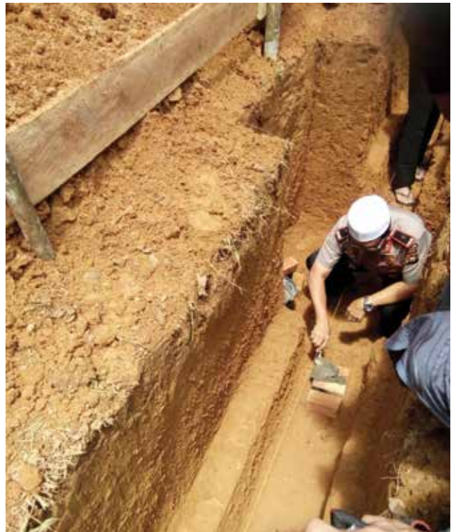
Peletakan Batu Pertama Pesantren Almukhlisah Groundbreaking of Almukhlisah Islamic Board School
